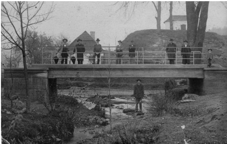
Dřívější betonový mostek přes Rokytenku – pohled proti proudu. V pozadí domek Pazourkových (později Felcmanových) a homole s kapličkou Ecce Homo. Těsně vpravo mohutná lípa zasypaná při regulaci až nad úroveň mostu. Snímek Z. Bureš.
